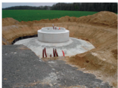
Photo 7 : Béton terminé (Photo : VALOREM)
