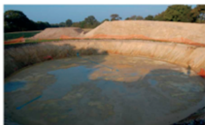
Photo 5 : Excavation (Photo : VALOREM)
