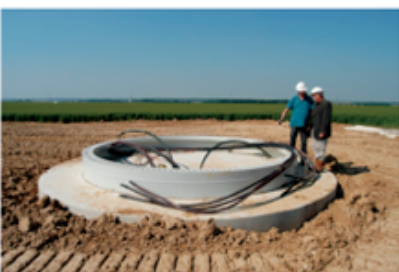
Photo 8 : Fondation terminée (Photo : VALOREM)
