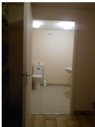
WC PMR Salle des fêtes - Lamativie
