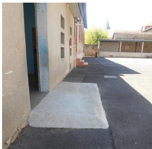
Rampe d'accès Ecole Gaston Monnerville
